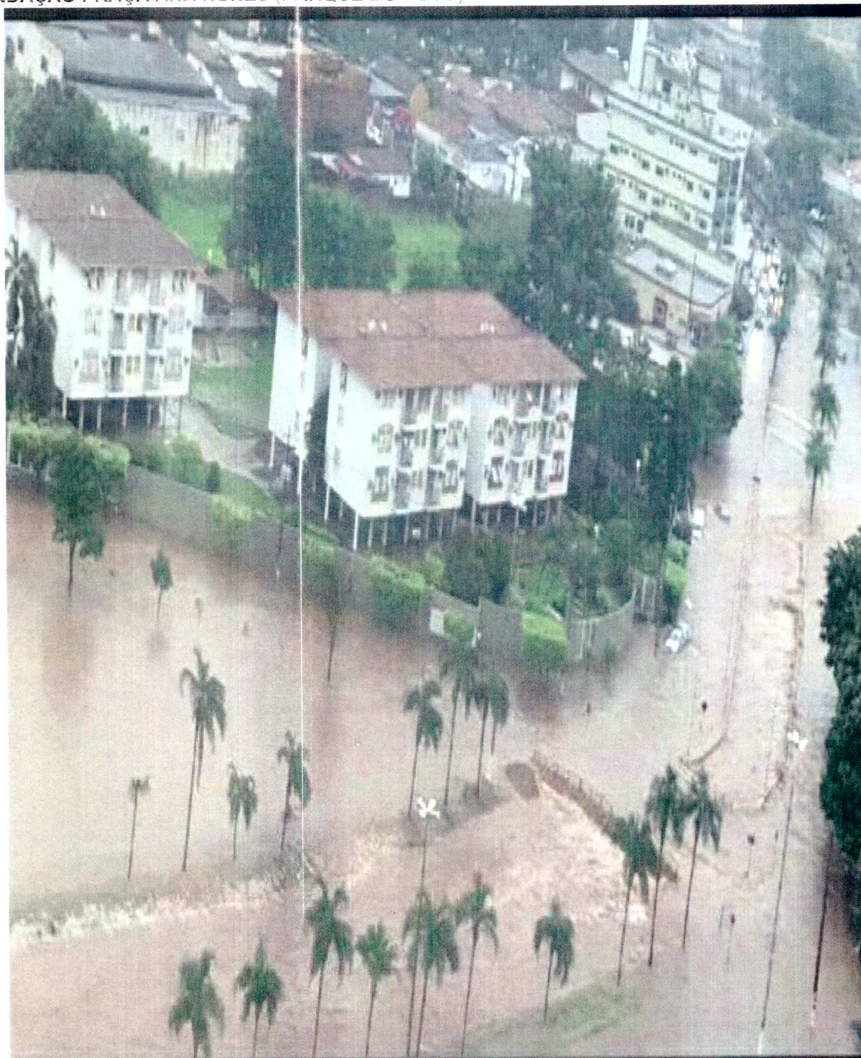
TRANSBORDAMENTO DO Córrego Biriguzinho X Córrego Parpinelli
