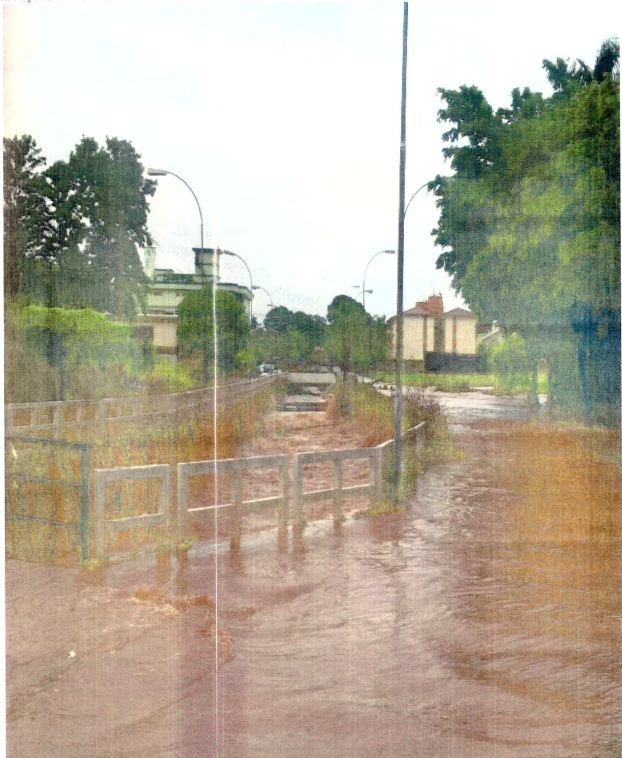
TRANSBORDAMENTO DO CÓRREGO BIRIGUIZINHO X CÓRREGO PARPINELLI
