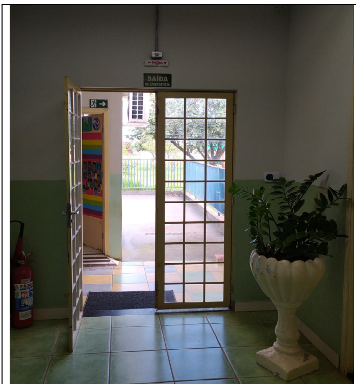
Sinalização de saída final de emergência e de indicação do sentido de uma saída de emergência.
