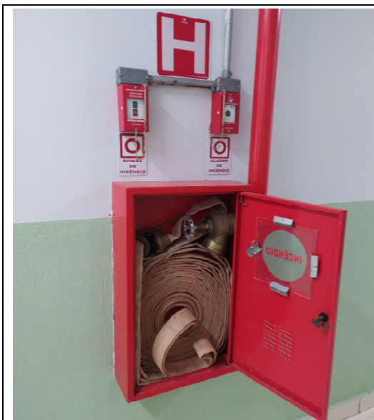
Abrigo do hidrante existente na edificação, sem esguicho regulável, com mangueira a ser substituída.
