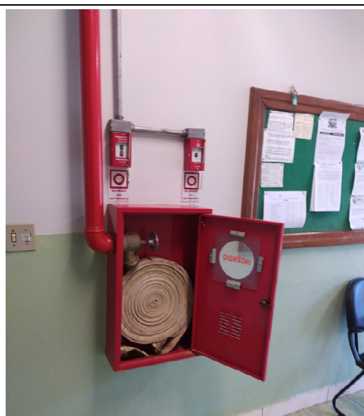
Abrigo do hidrante existente na edificação, sem esguicho regulável e chave storz, com mangueira a ser substituída.
