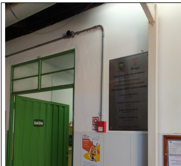
Acionador e sirene (sem sinalização) do sistema de alarme.
