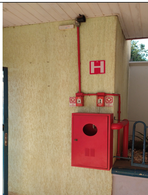
Acionador e sirene instalados na entrada da edificação
