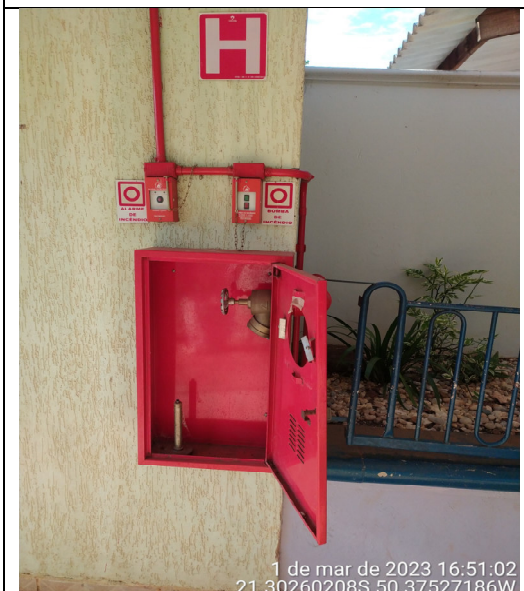
Abrigo do hidrante existente na edificação, sem esguicho regulável, chave storz e mangueira.
