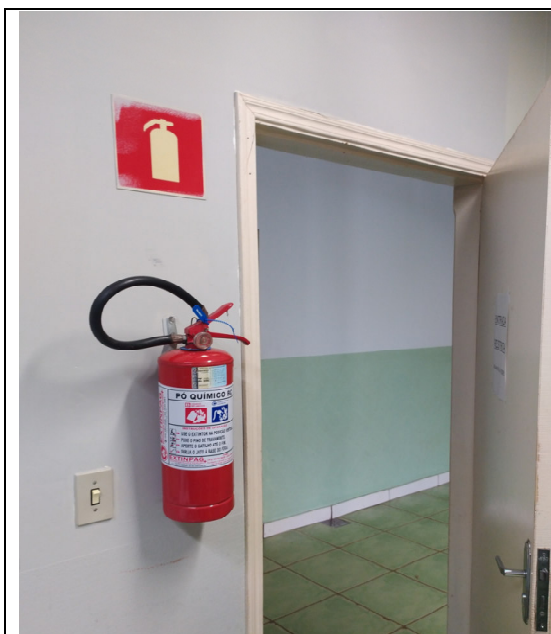
Extintor de Pó Químico Seco existente na edificação
