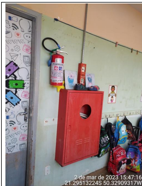
Equipamentos de alarme a serem sinalizados e desobstruídos.
