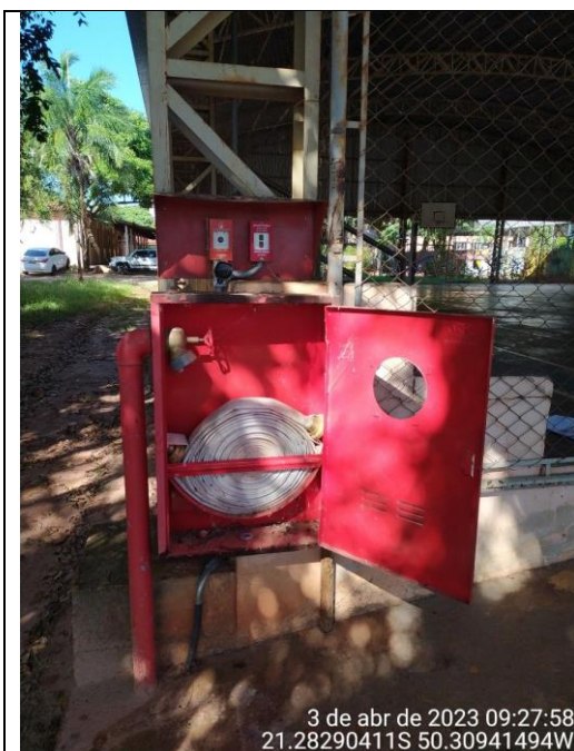
Abrigo de hidrante a ser substituído.
