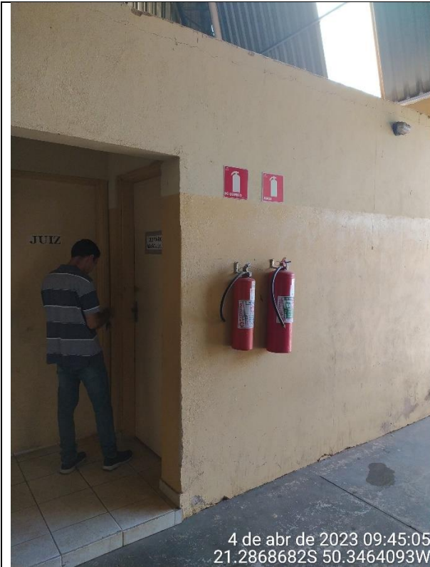
Extintores de água pressurizada e pó químico seco existentes na edificação.
