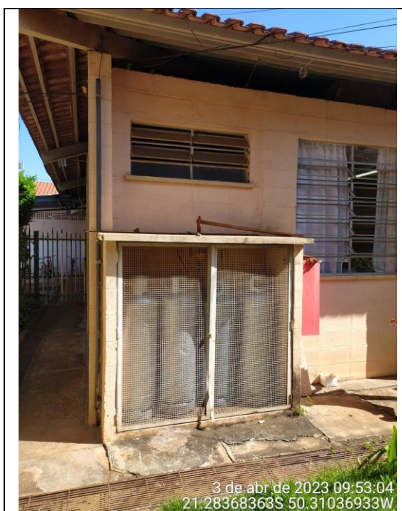
Central de GLP existente na edificação.
