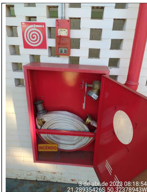
Abrigo de hidrante existente e devidamente sinalizado. Mangueiras a serem substituídas.
