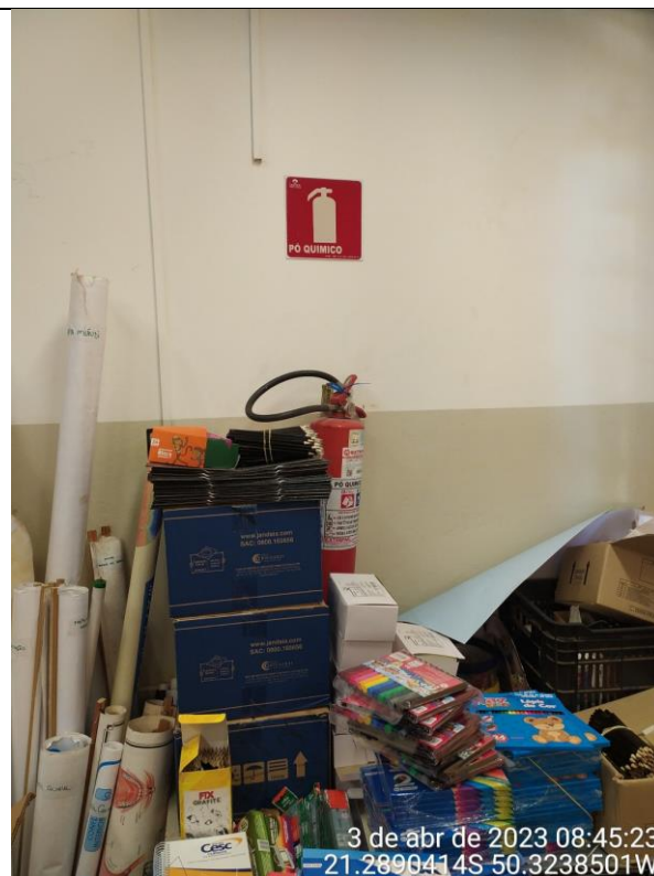
3 de abr de 2023 08:45:23 -21.2898414S 50.3238501W Extintor de pó químico seco a ser desobstruído.
