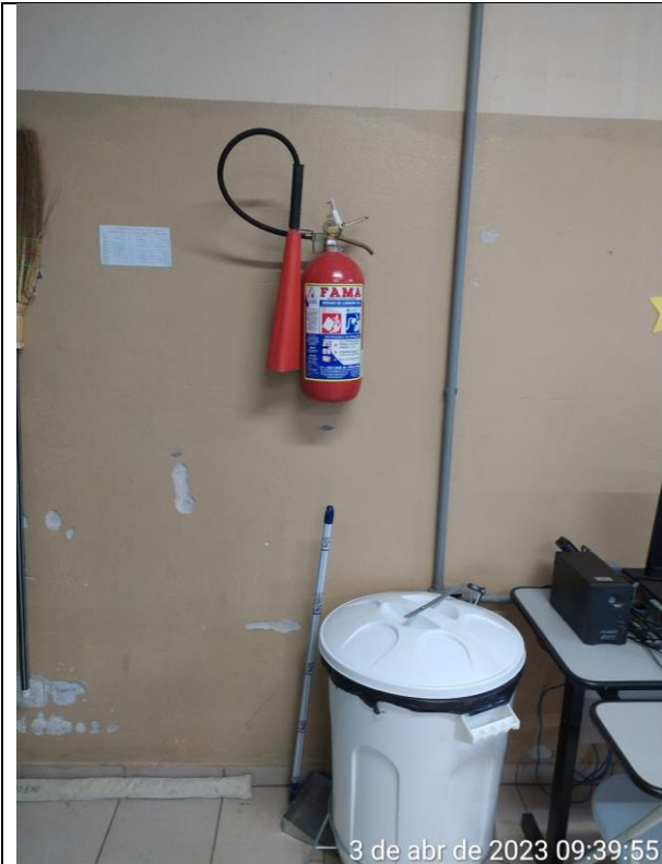
Extintor de Gás Carbônico a ser desobstruído e sinalizado.
