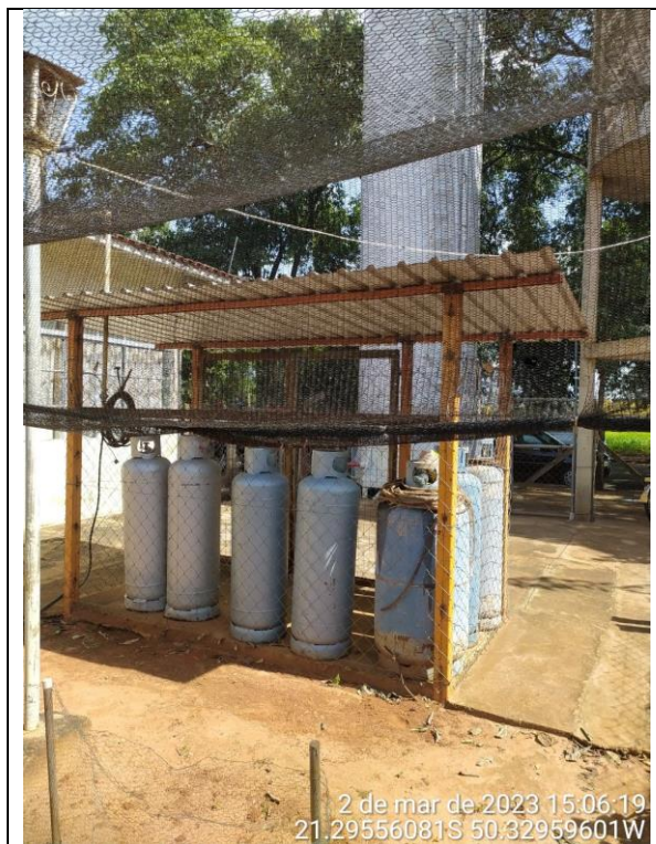
Central de GLP existente na edificação
