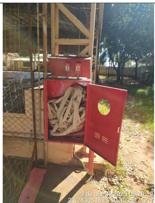
Abrigo de hidrante a ser substituído.
