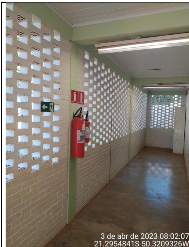
3 de abr de 2023 08:02:07 21.2954841S 50.3209326W Par de extintor existente na edificação – pó químico seco e água pressurizada.
