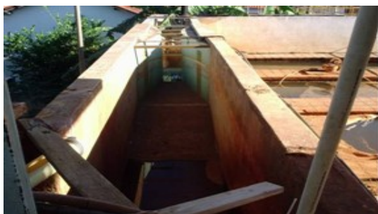
Figura 9 – Esquerda: Calha Parshall /Direita: Aplicação de Coagulantes
