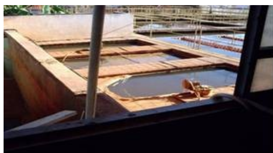
Figura 10 –Floculadores Antigos Atualmente Auxilia o Processo de Mistura
