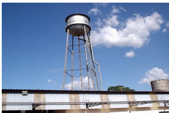
Figura 15– Reservatório Elevado em Estrutura Metálica - Anderson Clayton
