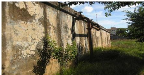
Figura 19 - Reservatório Isabel Marin – Detalhe com Trincas
