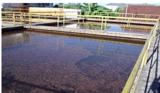
Figura 11 – Detalhe do Decantador com Flocos em Suspensão
