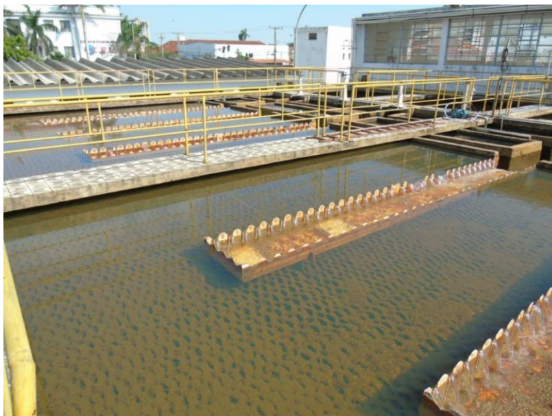
Foto 10 – Sistema de decantação
