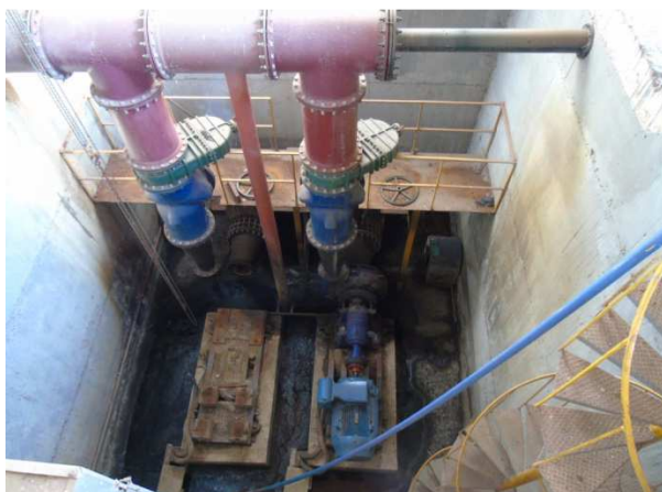
Foto 38 – Bombas para recalque Fonte: PROJEC.
