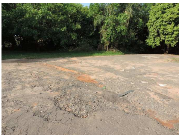
Foto 58 e 59 – Pontos de encaminhamento das águas pluviais sem estrutura adequada Fonte: PROJEC (2015)
