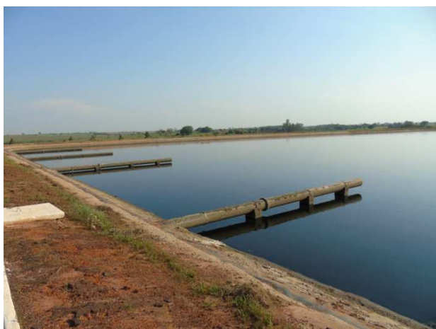
Foto 36 – Lagoa Anaerobia Fonte: PROJEC.
