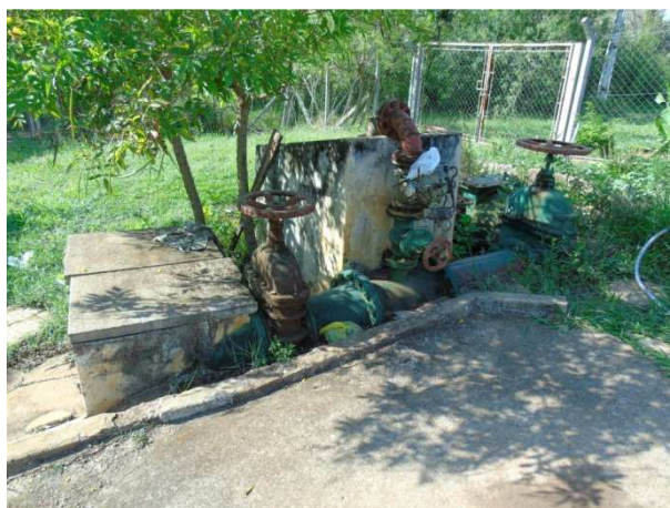
Foto 7 – Válvula antecipadora de onda – sistema desativado Fonte: PROJEC (2015)
