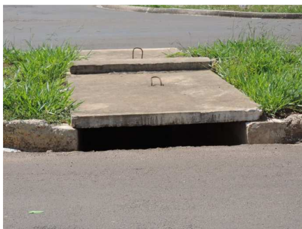
Foto 50 e 51 – Sarjetas, Meios-fios e Bocas de lobo existentes em ruas de Birigui Fonte: PROJEC (2015)
