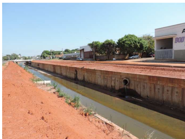
Foto 54 e 55 – Canais (córregos canalizados) a céu aberto na área urbana de Birigui
