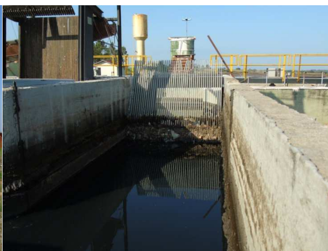
Foto 35 – Grade metálica para remoção de sólidos
