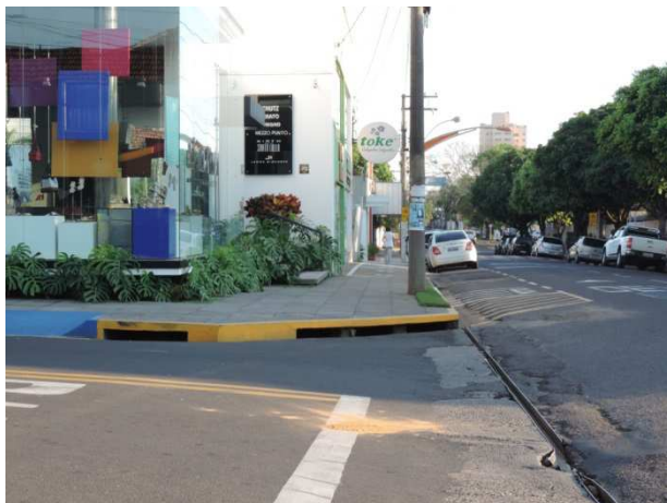
Foto 48 e 49 – Sarjetas, Meios-fios e Bocas de lobo existentes em ruas de Birigui Fonte: PROJEC (2015)
