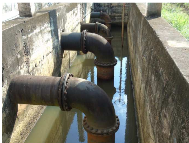
Foto 3 – Poço de sucção e conjunto de adutoras Fonte: PROJEC (2015)
