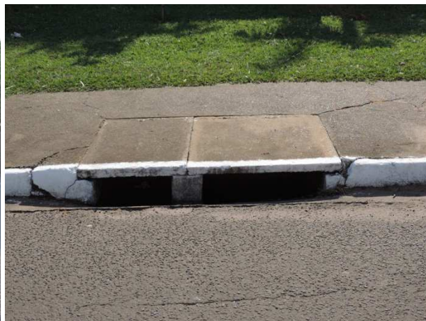
Foto 48 e 49 – Sarjetas, Meios-fios e Bocas de lobo existentes em ruas de Birigui Fonte: PROJEC (2015)
