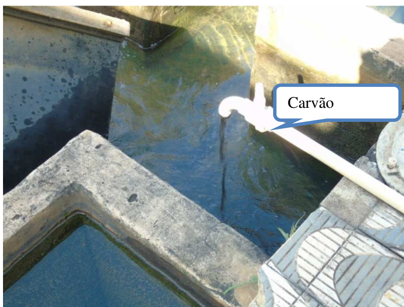
Foto 11 – Canaleta de condução da água para filtragem e adição de carvão ativado
