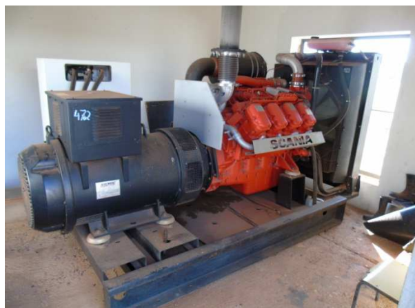
Foto 39 – Gerador de energia Fonte: PROJEC.
